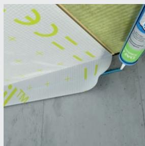
DAFA folieklæb udgør en lufttæt limning mellem dampspærrefolien og underlag som f.eks. puds, beton eller ubehandlet træ.
