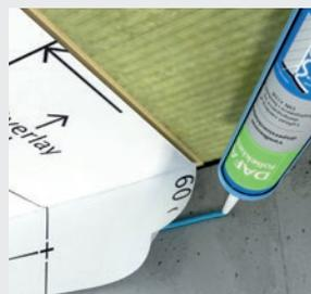
DAFA folieklæb udgør en lufttæt limning mellem den fugtadaptive dampspærre og underlag som f.eks. puds, beton eller ubehandlet træ.
