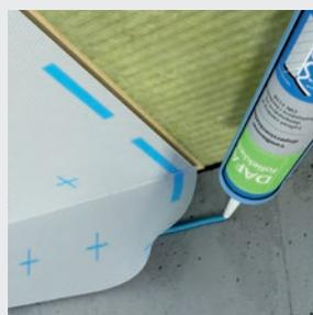
DAFA folieklæb udgør en tæt limning mellem dampbremsen og underlag som f.eks. puds, beton eller ubehandlet træ.
