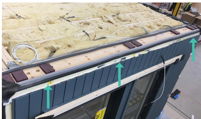
Specialproduceret tætningsløsning til modulbyggerier.
