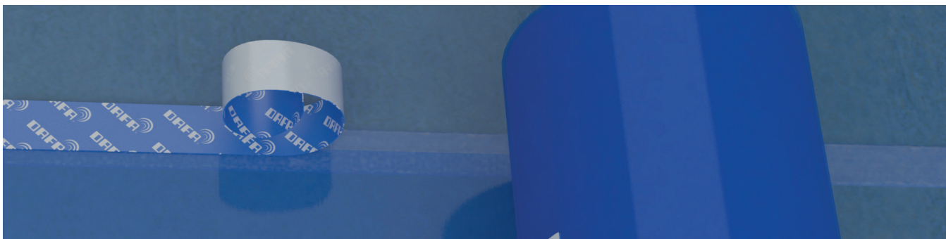
Dampsperrfolien monteres med overlegg og tapes med DAFA dampsperrtape.
